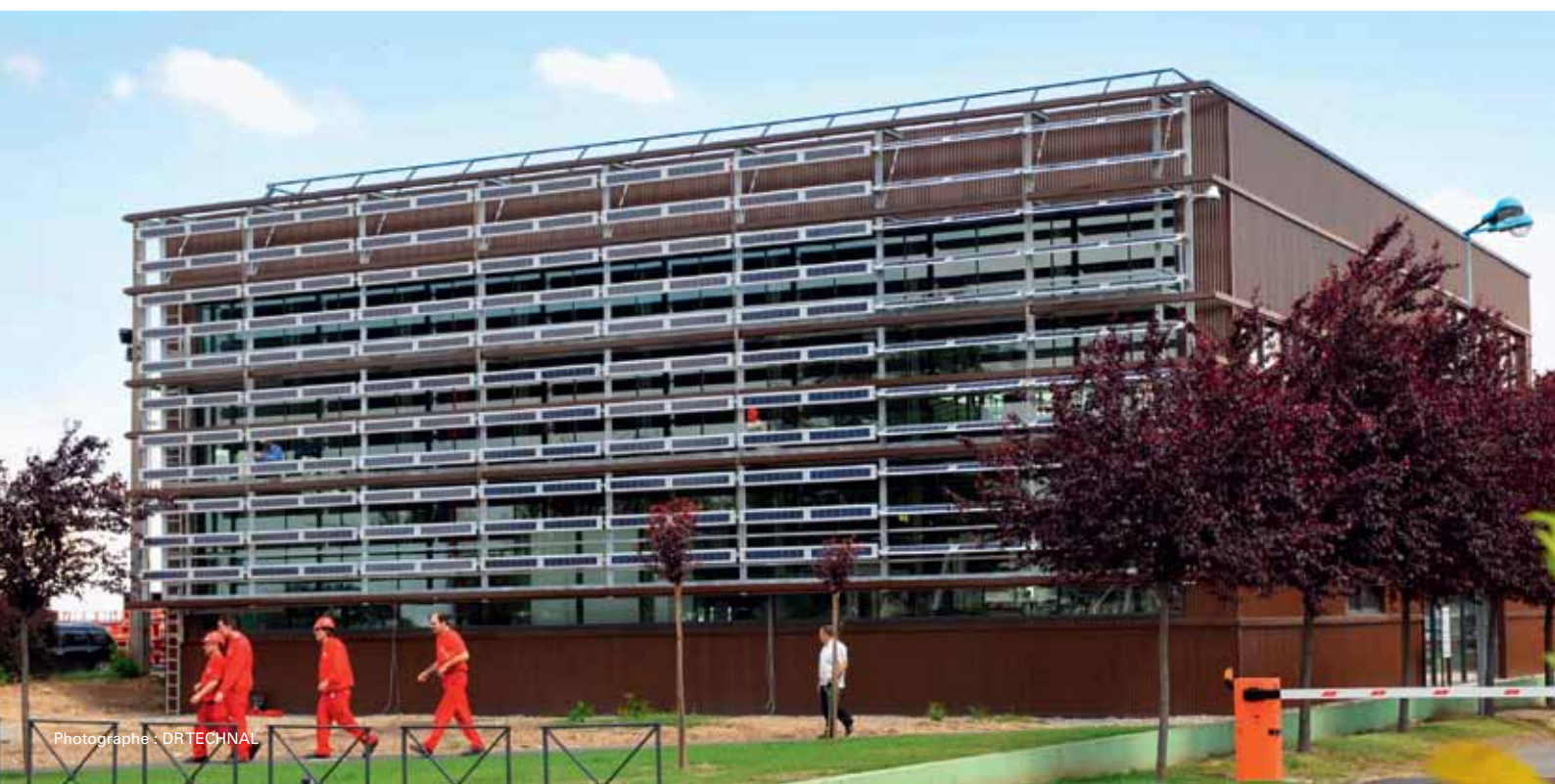
Fixation sur structure auto-porteuse indépendante de la façade
