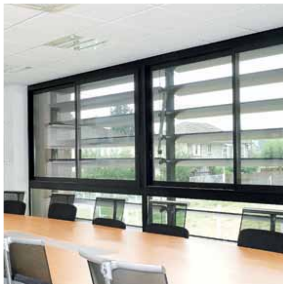
Lames de 300 mm motorisées - Inclinaison 15°
