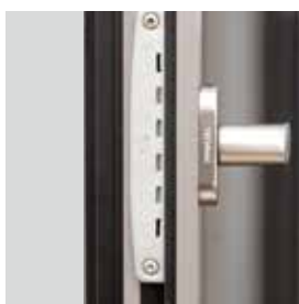
Manœuvre des fermetures par boîtier crémons bidirectionnel
